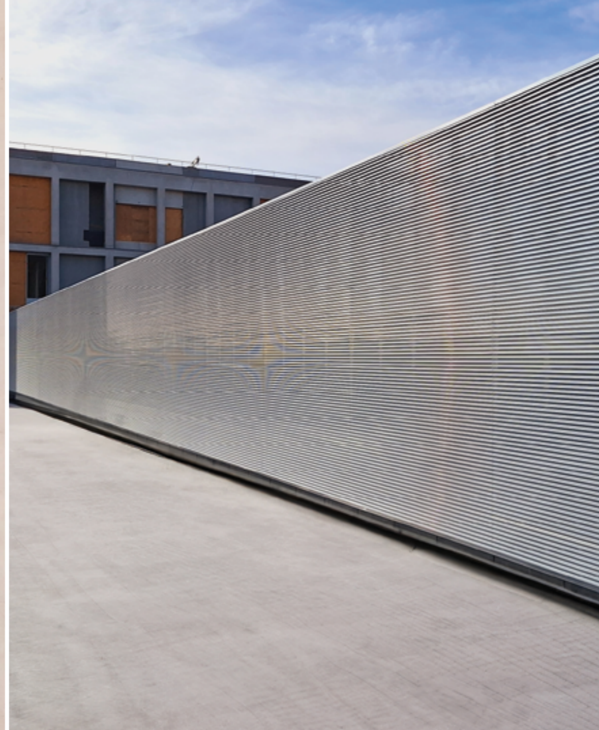
ANSES - LYON (69) Architecte : Pargade Pose : SOCAM
