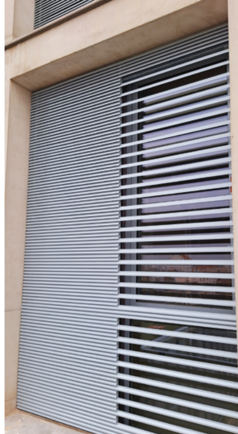
Bardage à ventelles FL340. Pose verticale sur porteurs TR15x30 et TR50x30 (RAL 9006 satiné).
