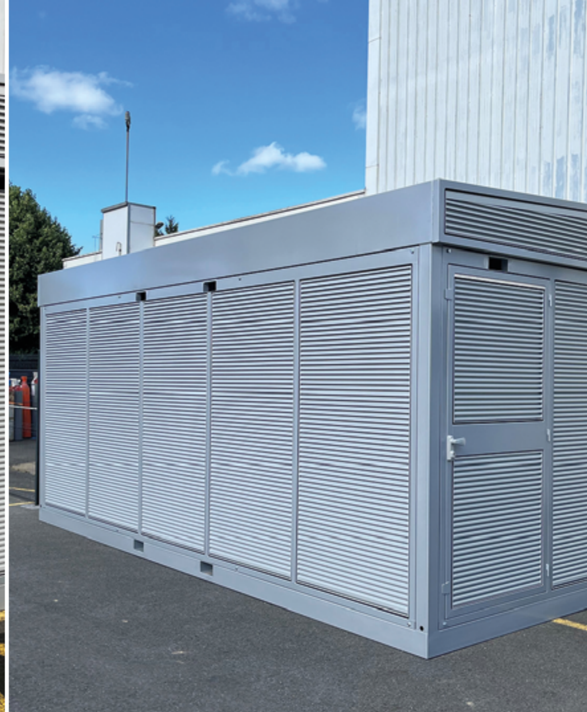
CETIM - NANTES (44) Pose : SAS SERMET
