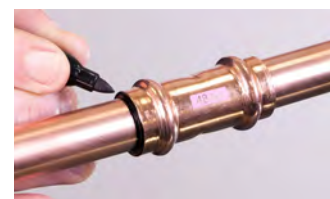
7B. Sinon, insérez le tube jusqu'à la butée du raccord et marquez-le.
