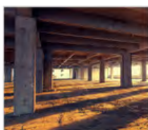
Relevé de l'état d'avancement des travaux
