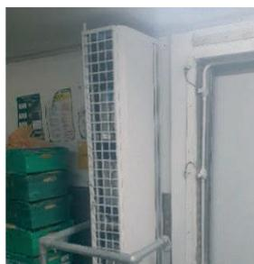
Les images prises avant l'installation montrent une importante accumulation de glace. Celles prises après l'installation présentent une porte dégagée, sans aucune glace, démontrant l'impact positif du rideau d'air.
