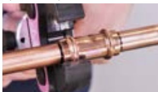
1. Positionnez les mâchoires d'équerre sur le raccord
