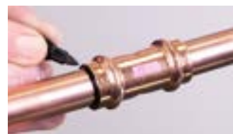
7B. Sinon, insérez le tube jusqu'à la butée du raccord et marquez-le.
