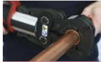
3. Effectuez le raccordement à l'aide de la sertisseuse.
