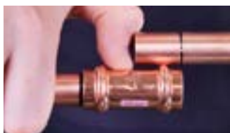
7B. Vérifiez la marque de profondeur
