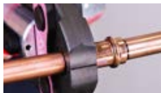
2. Effectuez le sertissage avec l'outil approuvé. Ne sertir qu'une seule fois
